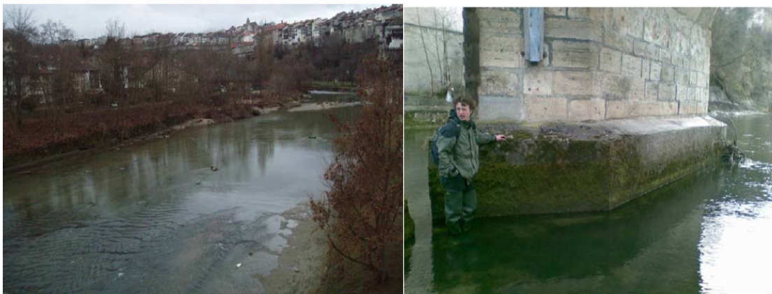
Figure 1. A gauche: La Sarine qui s'écoule sur un lit de molasse. A droite, exemple de l'incision du lit de la Sarine. Le socle du pilier du pont était anciennement enseveli sous les substrats (Marbach 2009).
